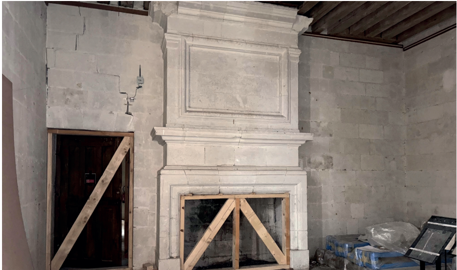
Salle 2.5.2 au R+2 - Fissures «en escalier» du mur de refend principal et de la cheminée. Photographie Maël de Quelen, ACMH, 2025
