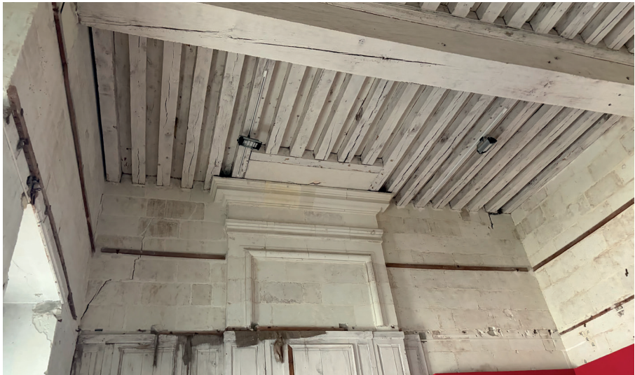
Salle 1.5.2 au R+1 - Fissure oblique du mur de refend principal. Photographie Maël de Quelen, ACMH, 2025
