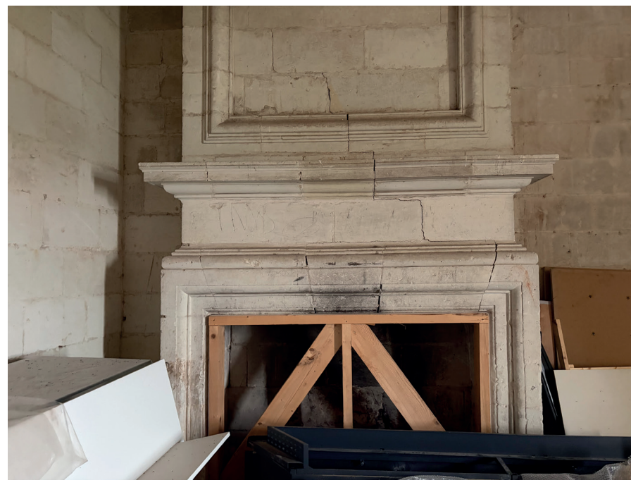
Manteau de cheminée endommagé, salle 2.5.4 Photographie Maël de Quelen, ACMH, 2025
