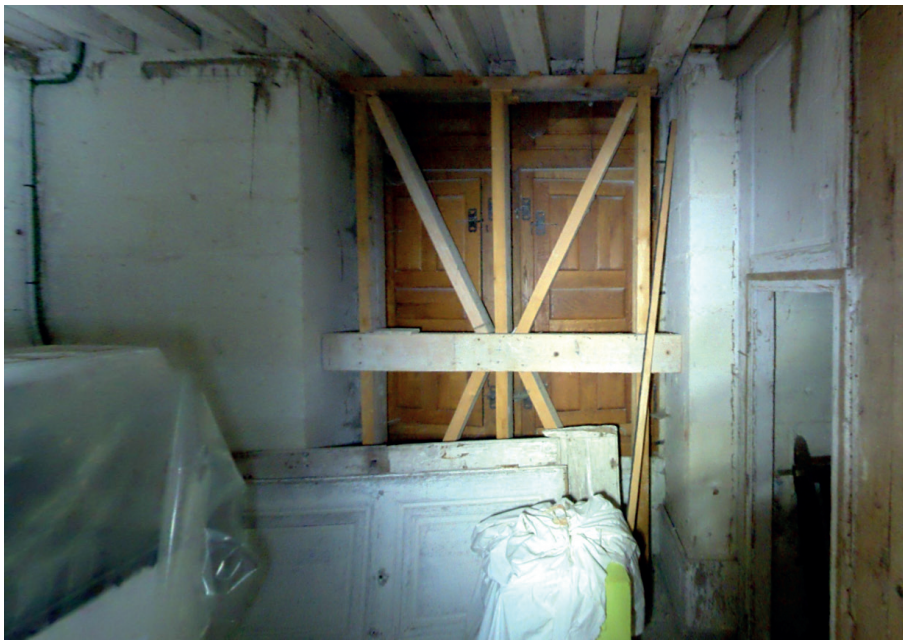
Absence d'appui du plancher, salle 1.5.1.a Photographie de Maël de Quelen, ACMH, 2025
