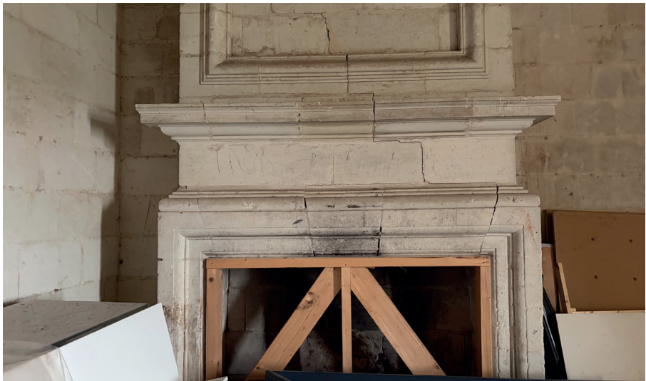
Salle 2.5.4 au R+2 - Fissure «en escalier» de la cheminée. Photographie Maël de Quelen, ACMH, 2025
